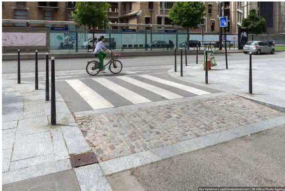
Exemple d'une intersection sécurisée par un marquage au sol, un changement de matériel de surface, une surélévation par rapport au niveau de la rue et des bornes de protection
