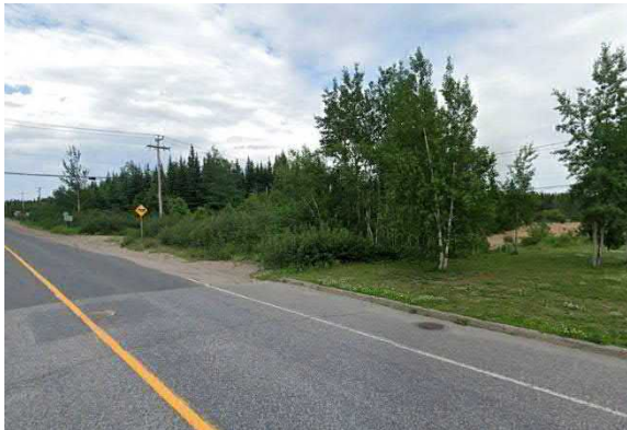
Prise de vue 8 - Localisation du fossé
