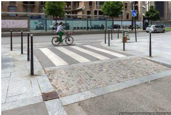
Exemple d'une intersection sécurisée par un marquage au sol, un changement de matériel de surface, une surélévation par rapport au niveau de la rue et des bornes de protection
