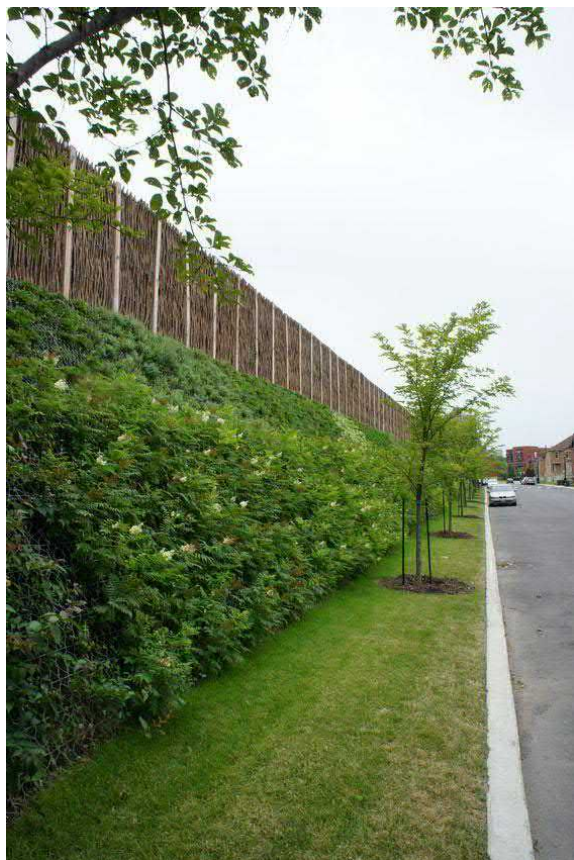
Exemple d'un écran antibruit végétalisé intégré à une zone tampon dans une zone résidentielle
