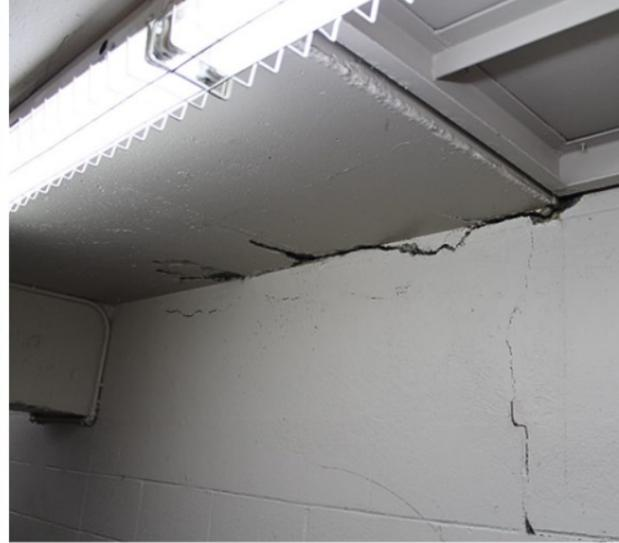
Fissures, infiltrations d'eau, corrosion des équipements, constituent des signes visibles de la désuétude de l'aréna Conrad-Parent.
